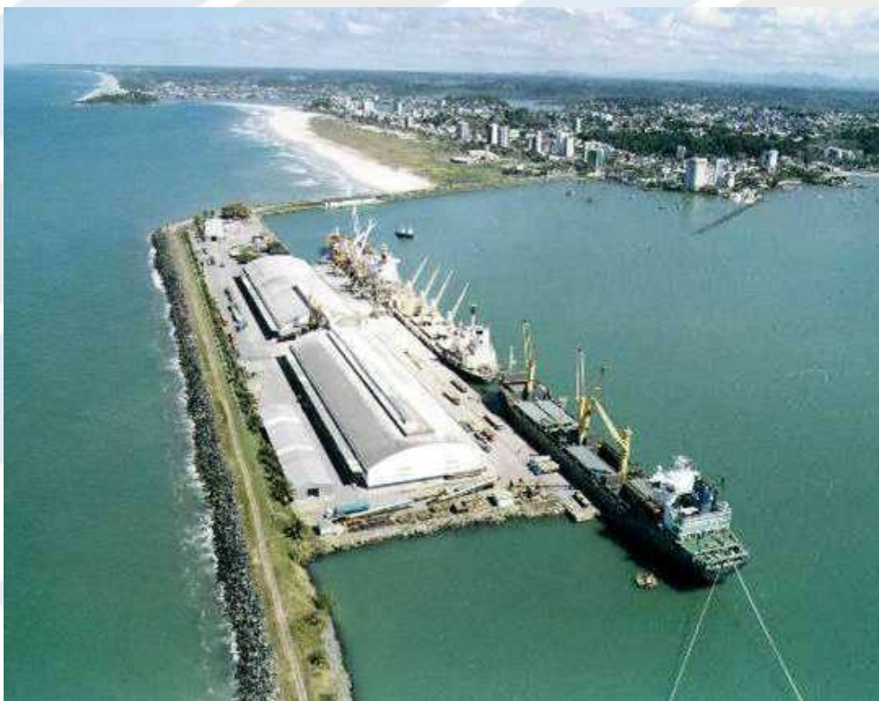
Figura 7 - Vista Aerea do Porto de Ilhéus
