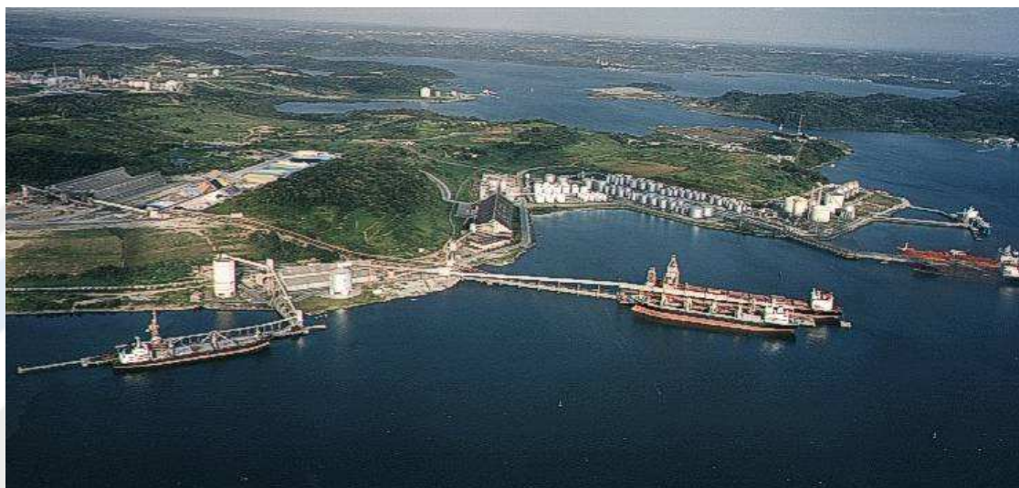
Figura 6 - Vista aérea do Porto de Aratu
